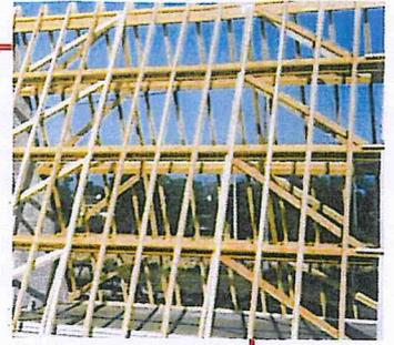
Utilisée en Pannes pour les charpentes, la poutre Mega Poutre s'adapte aux grandes parties et supporte des charges importantes. Sa légèreté facilite la rapidité de mise en oeuvre
